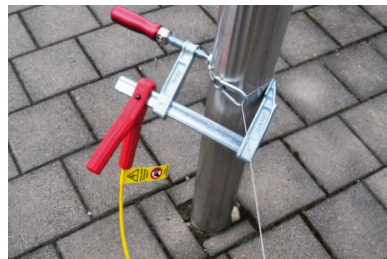
Erdung am Mast mit Hilfe einer Schraubzwinde
