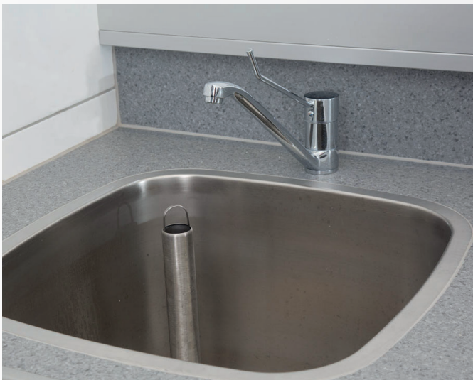
Becken mit Einhebelmischer
