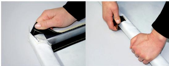
Das Tuch des Rauchverschlusses ist mittels Klettverschluss am Rahmen befestigt und kann somit leicht ausgewechselt werden. Das neue Tuch entsprechend dem alten Tuch montieren.
