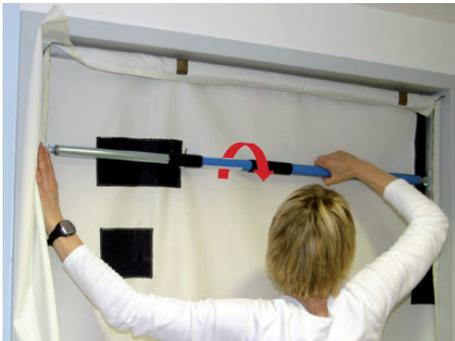
Mit der linken Hand den Rahmen fest gegen den oberen Türrahmen drücken und mit der rechten Hand die Spannvorrichtung in Pfeilrichtung **SPANNEN** drehen und den Rauchverschluss in der Tür verspannen.
