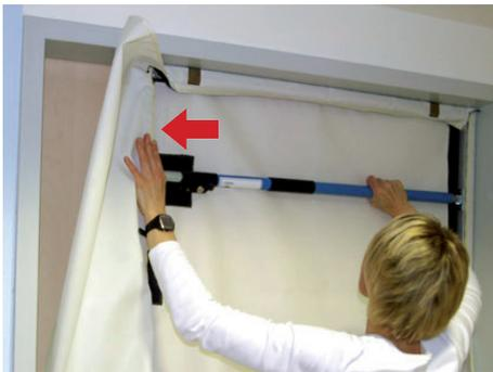
Mit der linken Hand die linke, verschiebbare Rahmenseite nach links schieben, um den Rauchverschluss auf die Türbereite einzustellen.
