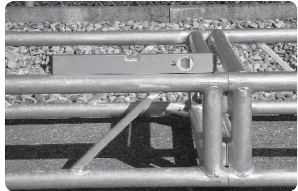
Mit den auf der Unterseite der Traversen eingeschraubten Sechskantschrauben M10 x 60 können Bodenunebenheiten ausgeglichen werden.
